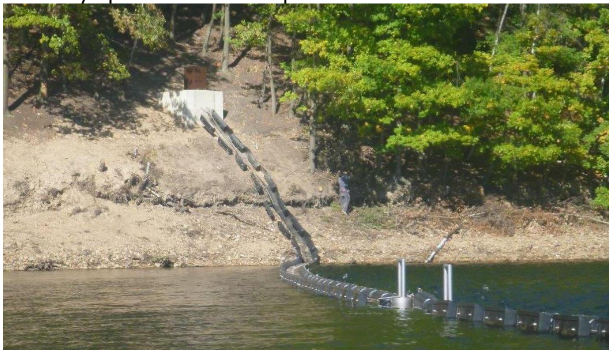
Betonový upevňovací blok na pravém břehu
