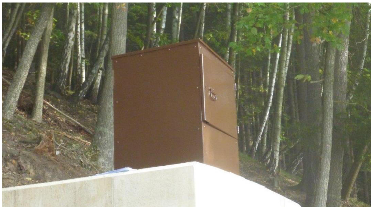
Kryt vrátku na betonovém kotvícím bloku
